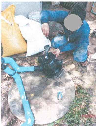
รูปภาพที่ 2.14 การตรวจสอบระบบท่อจ่ายน้ำ
